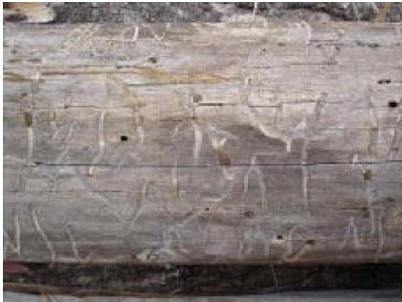
Daños en corteza causados por larvas de cerambícidos
